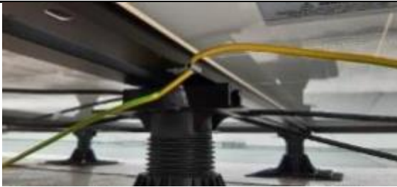
Mise à la terre module sur système Soprasolar Fix Evo par clip Rayvolt®
