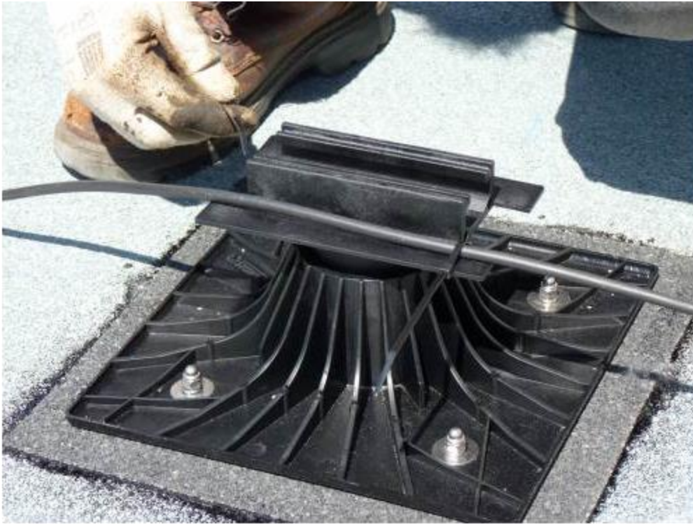
Figure 26 : Fixation câble électrique sur le plot à l'aide de Rislan
