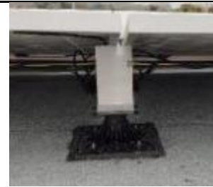
Mise à la terre réhausse 200 aluminium sur système Soprasolar Fix Evo TILT par clip Rayvolt®
