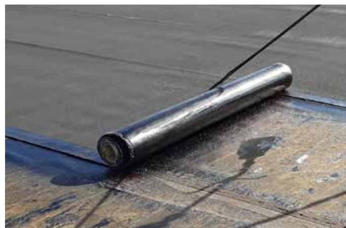
Membrane de la couche supérieure
