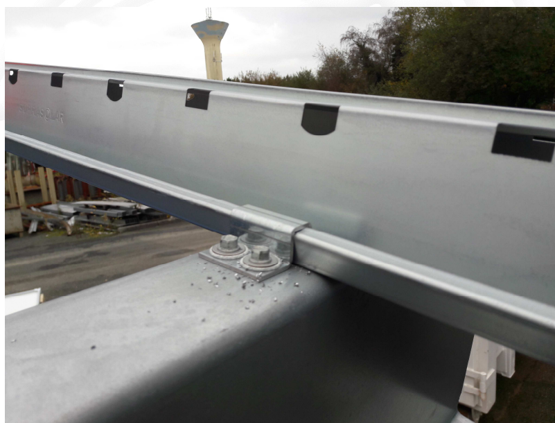
MISE EN ŒUVRE DU SOPRASOLAR CRAPAUD
