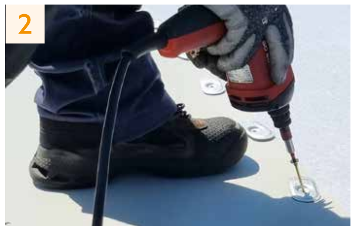
Fixer mécaniquement la membrane.
