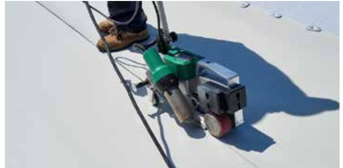
FLAGON EP/PR SC en TPO Épaisseur 1,8 mm minimum Largeur 1,05 m Fixée mécaniquement
