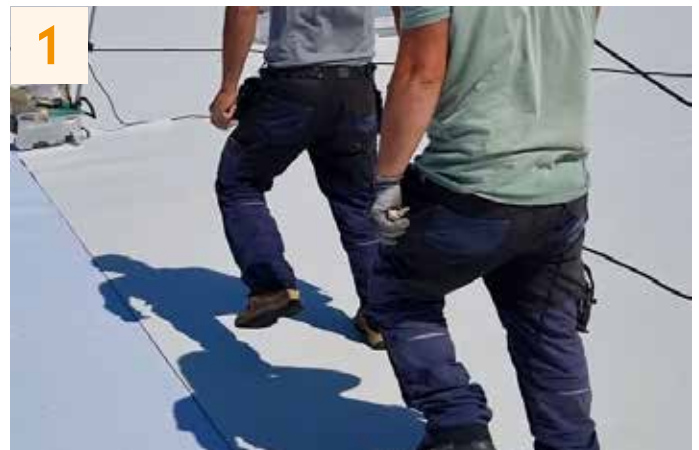
Tendre la membrane dans le sens long.
