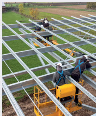
1 - Mise en place des rails Soprasolar® Park .
