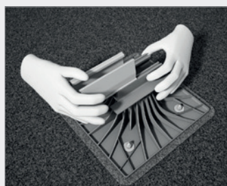
3 - Pose des rehausses.
