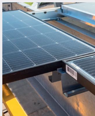
3 - Pose des modules sur les rails.
