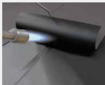
1 - Mise en œuvre de l'étanchéité SOPREMA sous AT sur isolant de classe C minimum.
