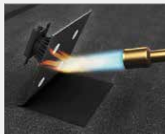
2 - Soudage en plein des plots à la flamme.
