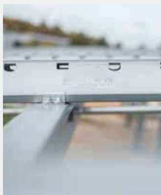
2 - Fixation des rails Soprasolar® Park aux panes par crapauds.
