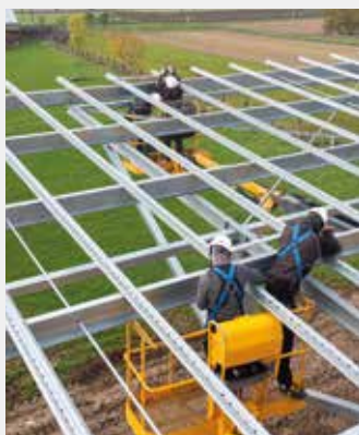
1 - Mise en place des rails Soprasolar® Park .
