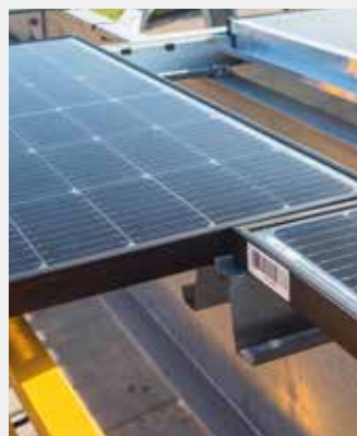
3 - Pose des modules sur les rails.
