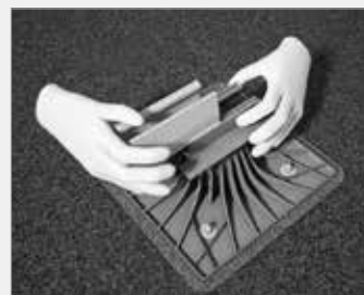
3 - Pose des rehausses.
