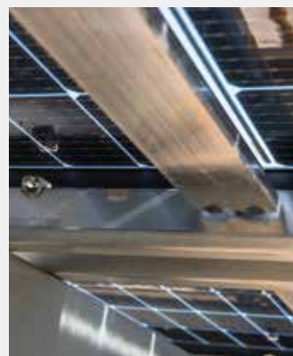
4 - Fixation des modules aux rails Soprasolar® Park avec le Soprasolar® Clips et raccordement électrique.
