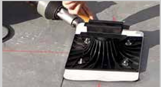
2- Soudure de l'autre côté du plastron sur 3cm de large minimum
