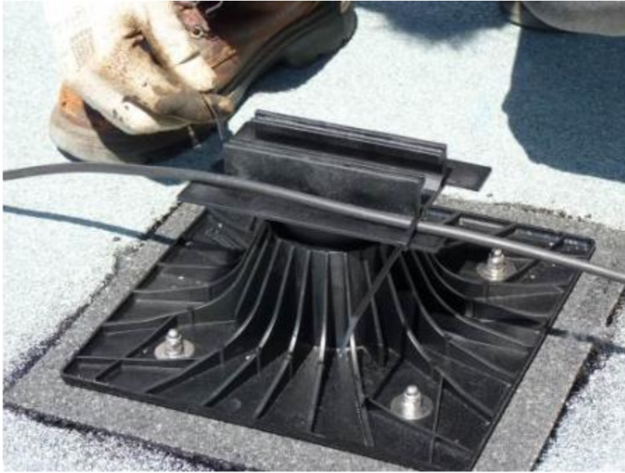
Figure 25 : Fixation câble électrique sur le plot à l'aide de Rislan
