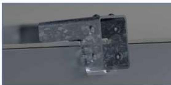
Figure 11 : mise en butée d'un Soprasolar Clip
