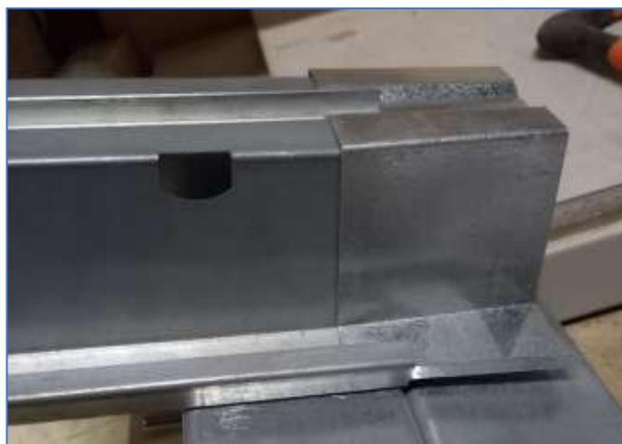
*Figure 2 : insertion de l'éclisse sur le rail bas*
