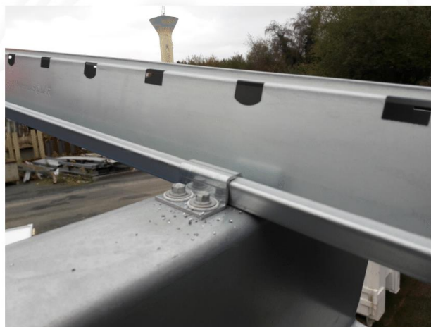
MISE EN ŒUVRE DU SOPRASOLAR CRAPAUD
