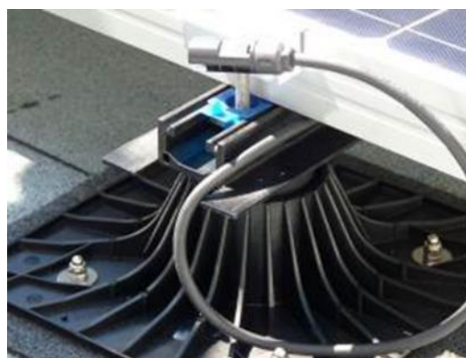
Figure 22 : Orientation de la tête du plot pour la pose du module photovoltaïque
