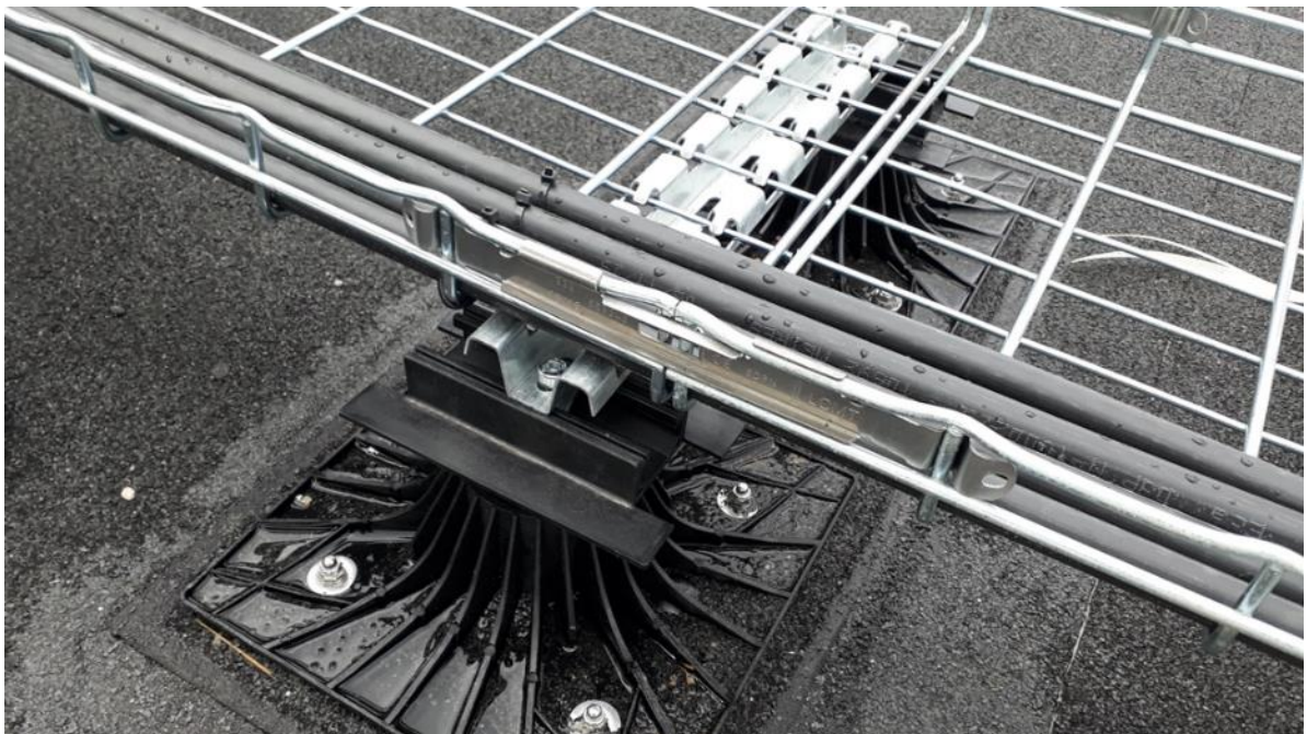
Figure 20 : Plots FIX EVO supports de chemin de câble
