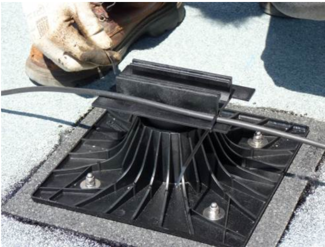
Figure 24 : Fixation câble électrique sur le plot standard à l'aide de collier Rislan et plot SOPRASOLAR FIX EVO -6- à l'aide d'un accessoire qui se fixe dans l'encoche de l'ailette
